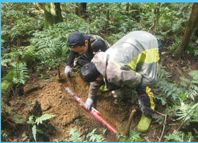
電磁探測棒埋設
