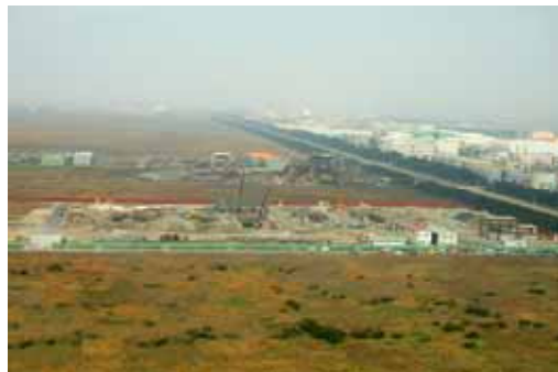
星元电厂厂址目前施工情形
